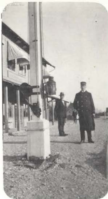
Stationsskrivare Erland Lindqvist poseerar utanför Klintehamns station, där han var anställd 1905—1910. På bilden syns tydligt konstruktionen av manöveranordningarna på den gamla tidens träsemaforer. Längst ner manöverhandtaget för semaforvingarna. Fotogenlyktan med ljusutsläpp åt två håll hissades upp med vinschen till vänster. Lyktan gled utmed ett T-format stålband upp till toppen, där de röd/grönfärgade "glasögonen", som var fästade på vardera vingen, fälldes framför lyktans ljusöppningar. Foto från W Lindqvist-Johansson.
