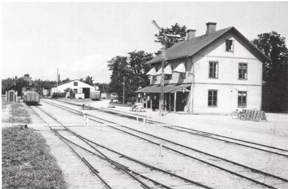
Klintehamns järnvägsstation. Bilden är tagen söderifrån i slutet av 40-talet och visar förutom stationsbyggnaden även lokstallet och verkstaden. Foto W Falcks arkiv.
