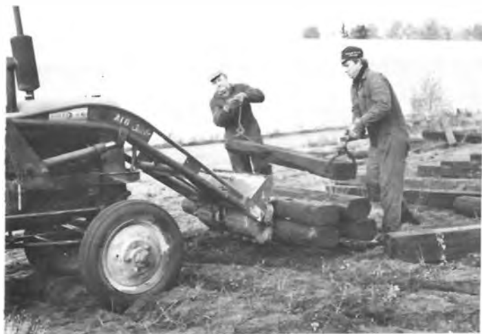
8. Det är inte bara rälerna som är tunga. Att lasta slipers en hel dag medför att man kan klia sig under fotsulorna på kvällen utan skador — näja ett par klämda tår och fingrar måste man räkna med. Här är det Bertil och Gösta som suger i. 70 kg väger en normalspårssliper (vi provvägde en ganska torr en). Dom här var ganska blöta.
